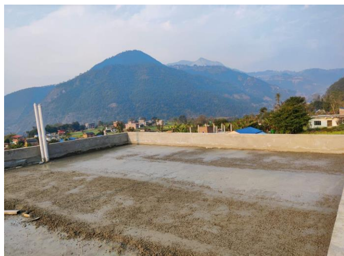
Lavori di manutenzione straordinaria della Happy Home
