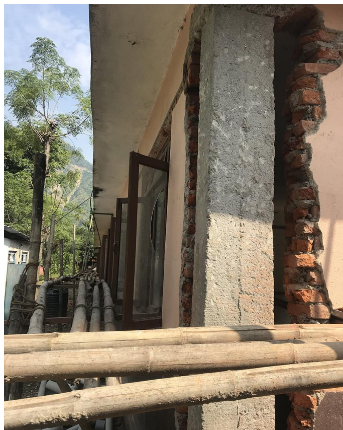
Opere di consolidamento alla Chandrodarya
