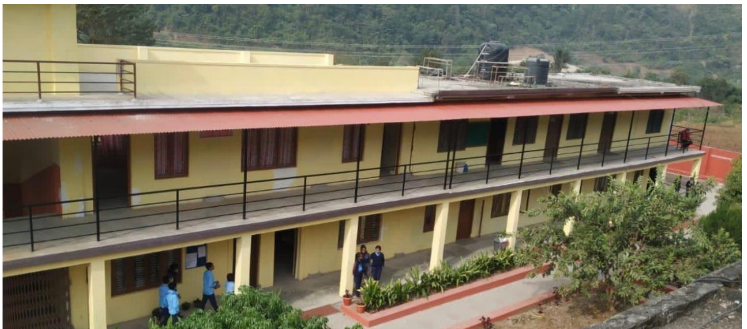
L'ala della Chandrodaya a lavori ultimati
