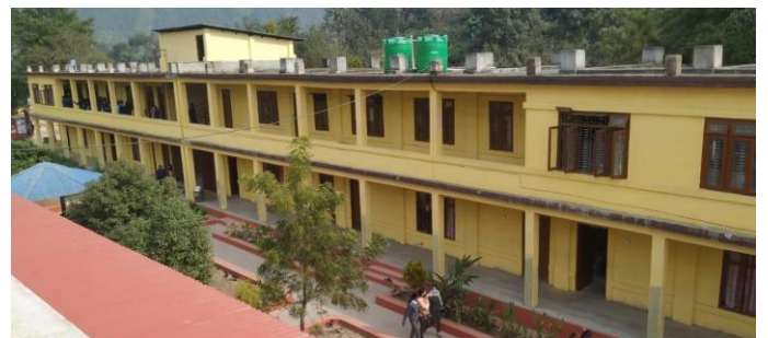
L'ala della Chandrodaya a lavori ultimati
