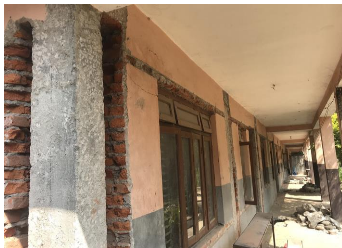
Opere di consolidamento alla Chandrodarya
