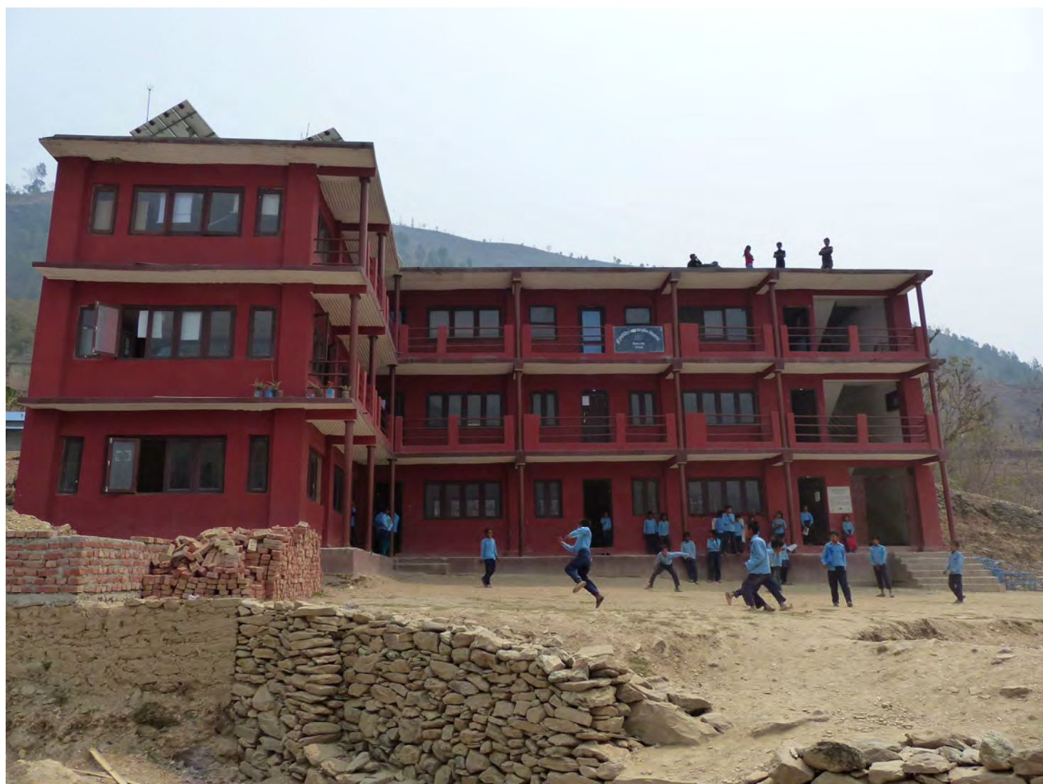
La Pragatishil High School dopo la ricostruzione
